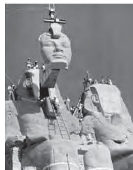
Fig. 233: I templi di Abu Simbel, minacciati dalle acque del Nilo, furono smontati e ricostruiti più in alto.
