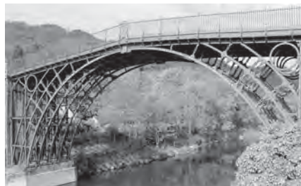
Fig. 246: Ponte di ferro dell'Ironbridge Gorge (Gran Bretagna).
