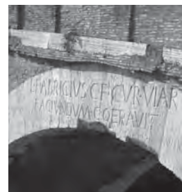
Fig. 158: Ponte dei Quattro Capi a Roma. Sull'arcata si conserva l'iscrizione del curator viarum (soprintendente alla costruzione e manutenzione della rete viaria dell'impero), Lucio Fabrizio, che fece costruire e collaudò il ponte.
