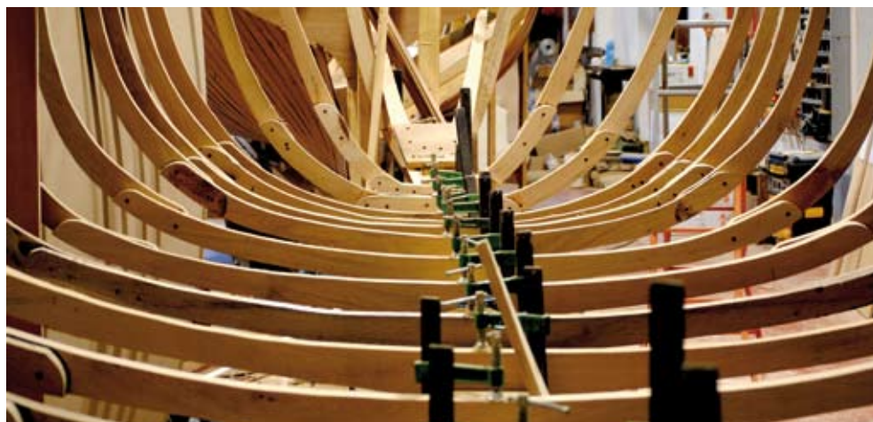
8. La struttura dell'ossatura del nuovo la palischermo di nave Vespucci realizzato dalla ditta Moroni 8. The ribs of a new launch for the training ship Vespucci under construction at Moroni Navi
