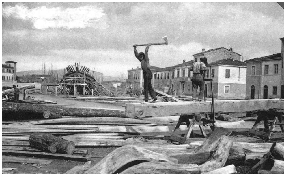
45. Via Coppino, un cantiere nell'area davanti alla Darsena Nuovissima, oggi Darsena "Italia" 45. A shipyard in the street – Via Coppino – leading to Darsena Nuovissima (now known as Darsena Italia)
