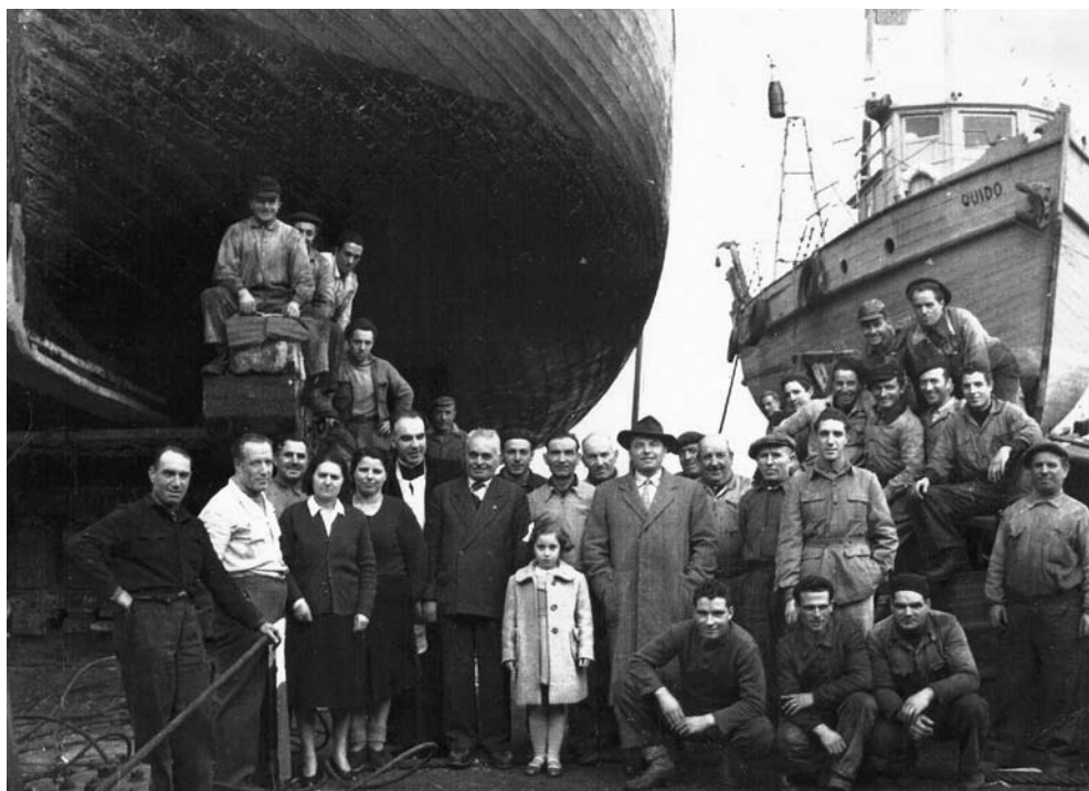
17. Le maestranze del Cantiere Argo sotto la carena della nave Speranza (1953) 17. The craftsmen of the Cantiere Argo in front of the hull of the Speranza (1953)
