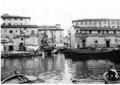
54. La sede della Cooperativa Carpentieri e Calafati (CCC), fondata dai maestri d'ascia, carpentieri e calafati livornesi nel 1932
