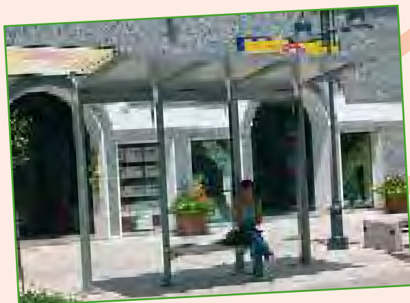
... e pensiline fotovoltaiche
